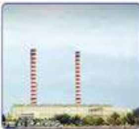
محطة تحلية مياه البحر
