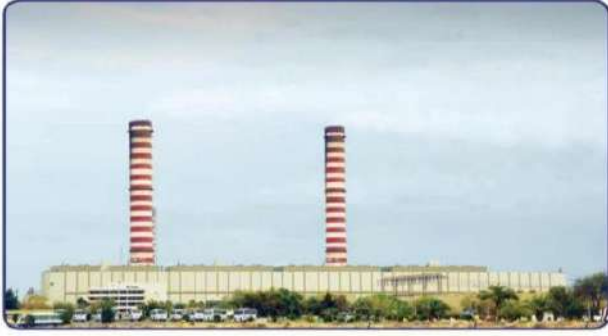
محطة تحلية مياه البحر
