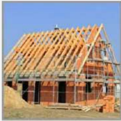
construction site ▶ موقع البناء
