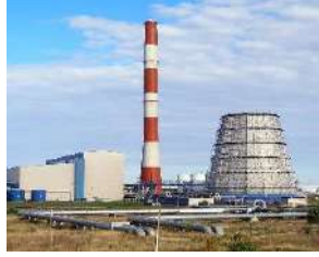
تحليه مياه البحر
